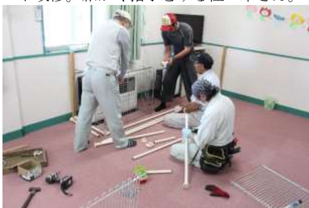
再利用できるものを確認しながら。高さ と位置を決めてパイプをカットしていきま す。
